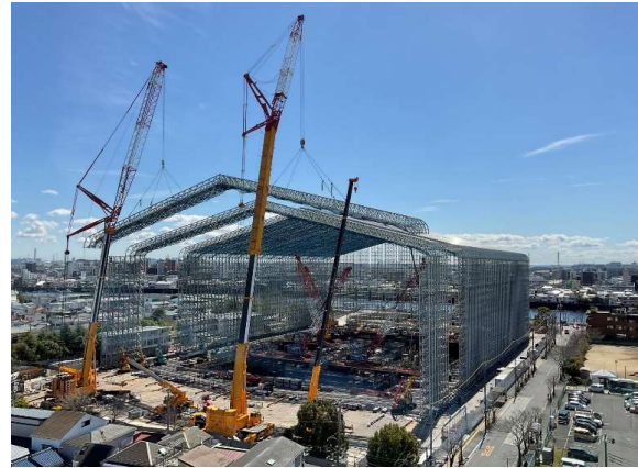
【工事状況写真】(令和6年3月)
