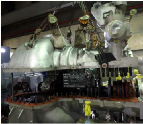
【蒸気タービンの開放点検(発電設備)】
