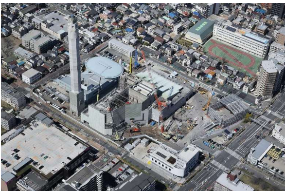
【工事状況写真】(令和6年3月)
