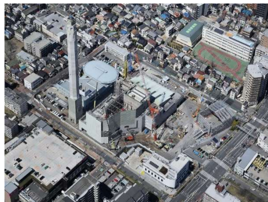
【建替工事(北清掃工場)】
