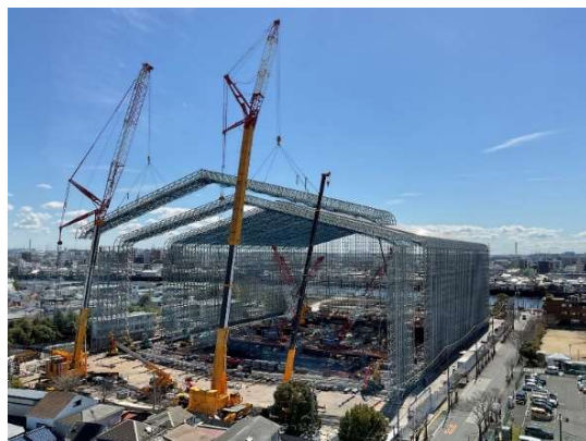
【建替工事(江戸川清掃工場)】
