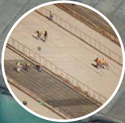
CARA DE HORMIGÓN 51.600 m 3
