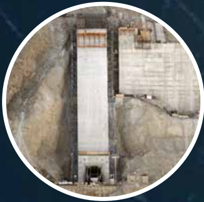
BOCA TOMA GALERÍA DE ADUCCIÓN LONGITUD DEL TÚNEL: 229 m DIÁMETRO INTERNO DEL TÚNEL: 5,50 m
