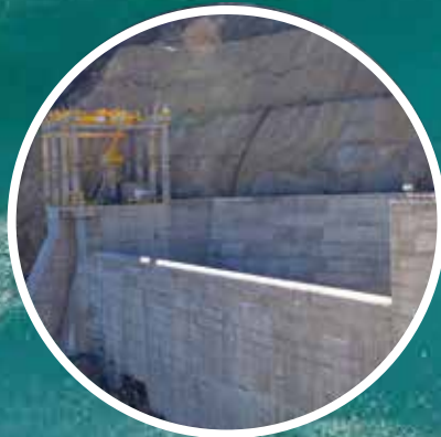
ALIVIADERO CANAL RECTANGULAR DE 230 m DE LONGITUD Y 25 m DE ANCHO CAUDAL MÁXIMO DE EVACUACIÓN 3.200 m 3 /s
