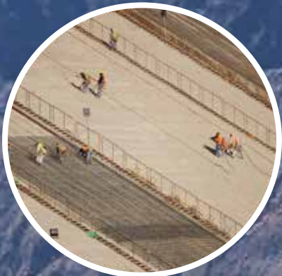
CARA DE HORMIGÓN SUPERFICIE 76.000 m 2
