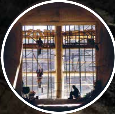
BOCA TOMA GALERÍA DE ADUCCIÓN LONGITUD DEL TÚNEL: 1.426 m DIÁMETRO INTERNO DEL TÚNEL :5,50m
