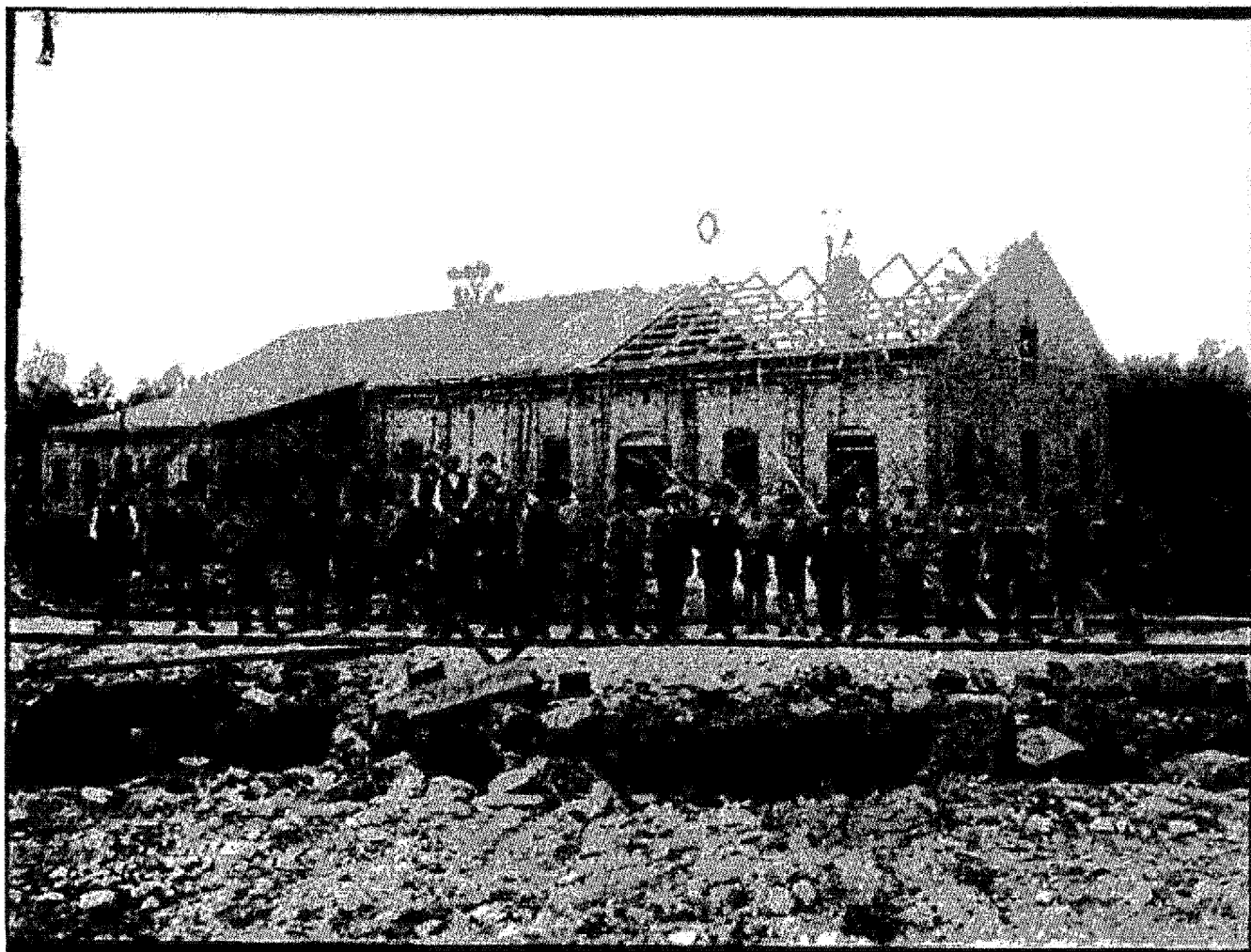
Ventilfabriken vid Engelsbergs Bruk uppfördes 1917 som en lancashiresmedja för tillverkning av smidbart järn åt Avesta Jernverk. 2011-2016 renoverades byggnaden. Idag arrangeras bland annat seminarier i regi av Nordstjernen samt Axel och Margaret Ax:son Johnsons stiftelse för allmännyttiga ändamål i Ventilfabriken. \s
